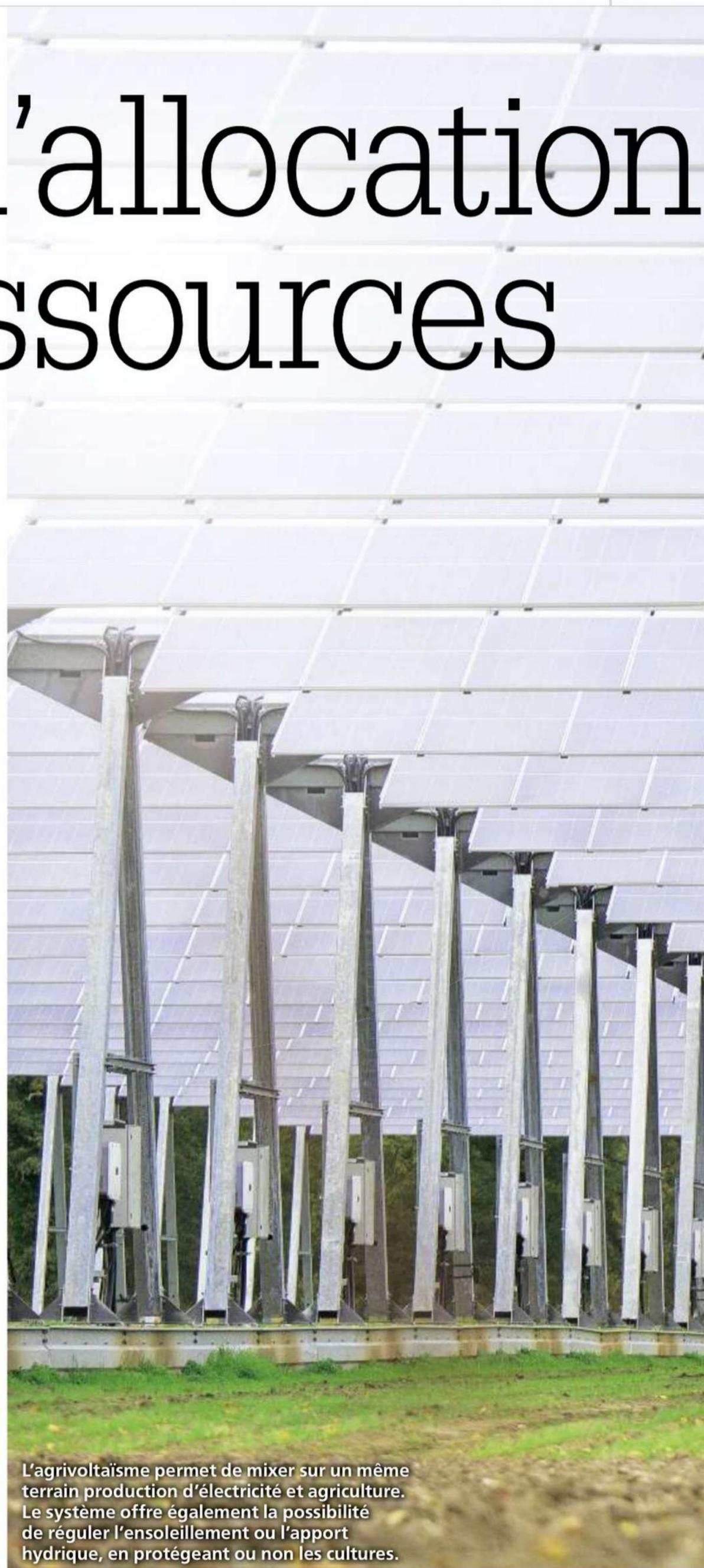
L'agrivoltaïsme permet de mixer sur un même terrain production d'électricité et agriculture. Le système offre également la possibilité de réguler l'ensoleillement ou l'apport hydrique, en protégeant ou non les cultures.
